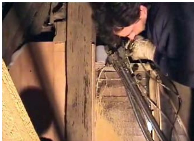
Сл. 6 Уливање полиуретана у посебно припремљени простор затворен плексигласом
