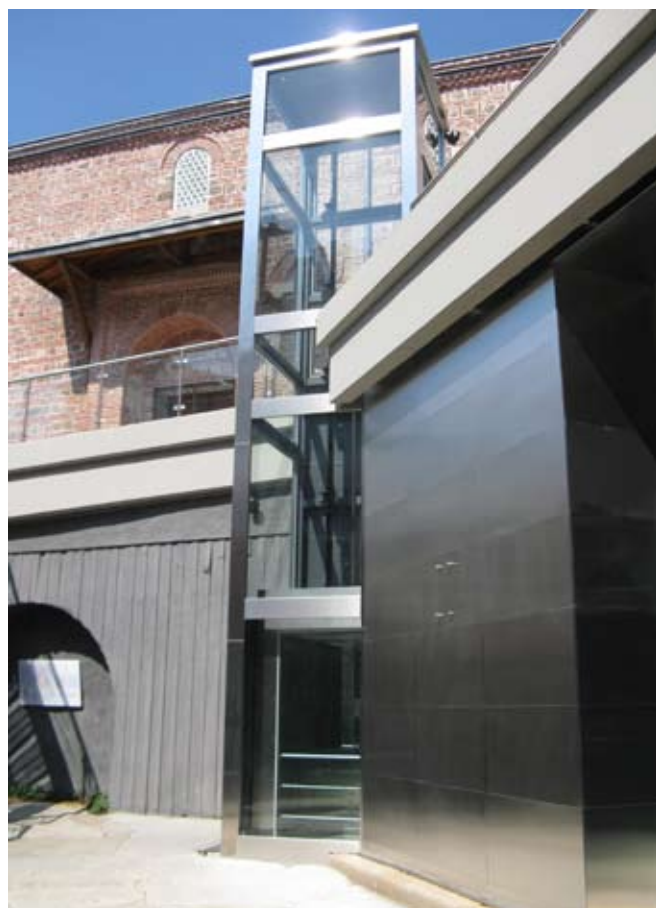
Сл. 14 Лифт ка подземном археолошком нивоу. У будућем, аудиовизуелном спектаклу „Звук и светлост“, лифт ће такође имати информационе функције
