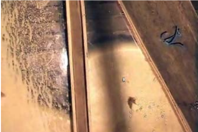
Сл. 7 Експандирање полиуретана, попуњавање шупљина
