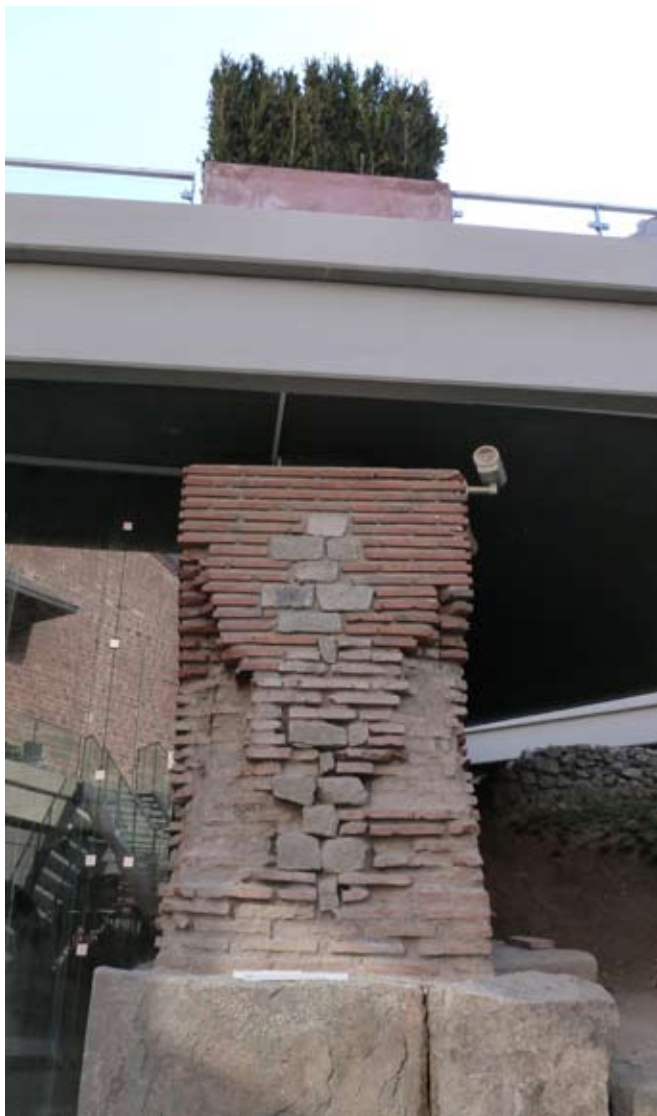
Сл. 12 Недостајућа материја стубова аквадукта изнад нивоа трга је интерпретирана помоћу зеленила као визуелног продужетка оригинала
