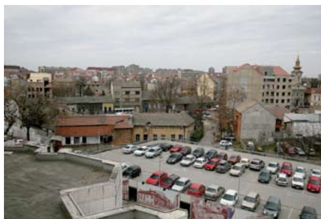
Сл. 7 Нова изградња у зони „урбане реконструкције“
