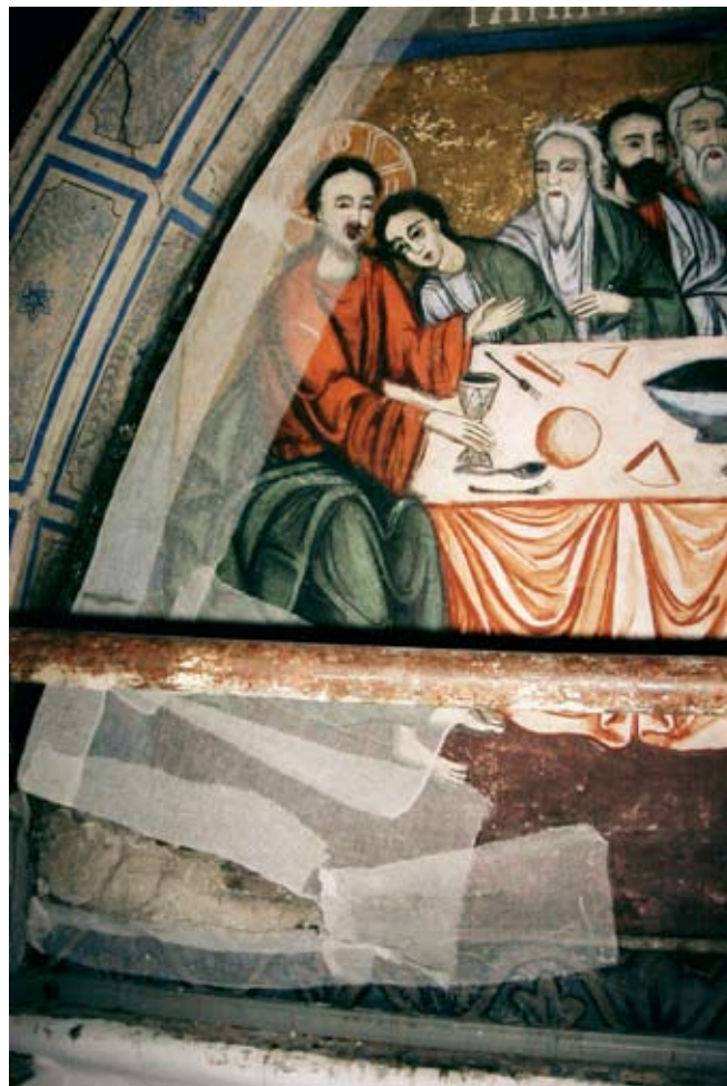
Сл. 2 Превентивна заштита пре постављања заштитне оплате
